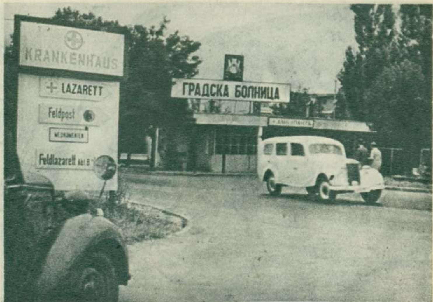
121 查内开足马力，飞一般地开到预定地点，在S医院右侧的路口停住。
